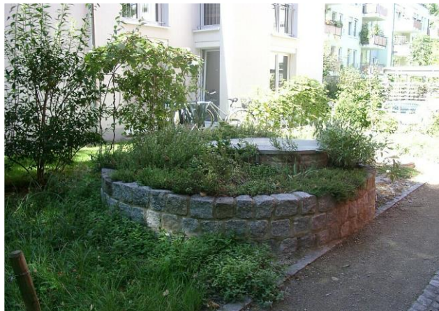
Figuur 4. Zichtbaar deel van een biogasinstallatie die werkt op menselijke uitwerpselen (Bron: Project Wohnen&Arbeiten in Freiburg/Duitsland)
